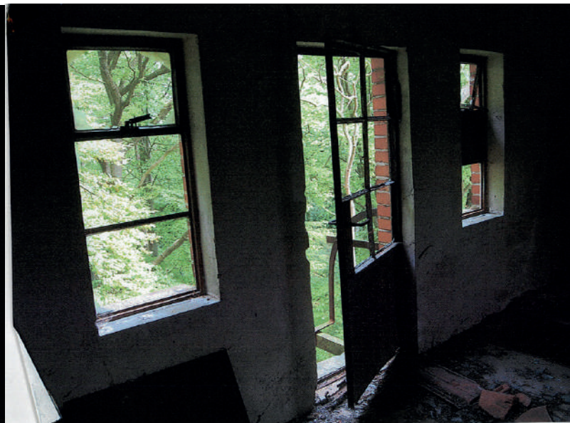
Innenansicht Dachgeschoss, OG Blick zum Wallberg
