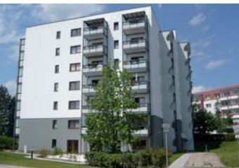
Altengerechtes Wohnen, Modernisierung und Instandsetzung, Wismar
