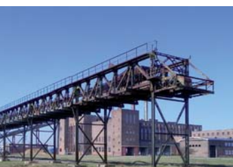
Kraftwerk Peenemünde Sanierung Peenemünde
