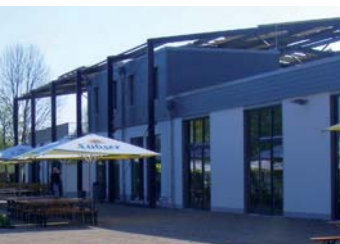
Vereinsgebäude Schweriner Rudergesellschaft, Neubau, Schwerin
