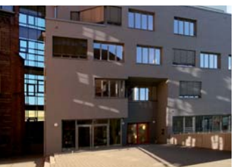
Niels-Stensen-Schule, Sanierung und Umbau mit Erweiterung (Neubau) Schwerin
